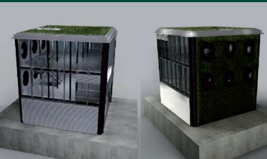
Posibles configuraciones de la envolvente de KUBIK.
