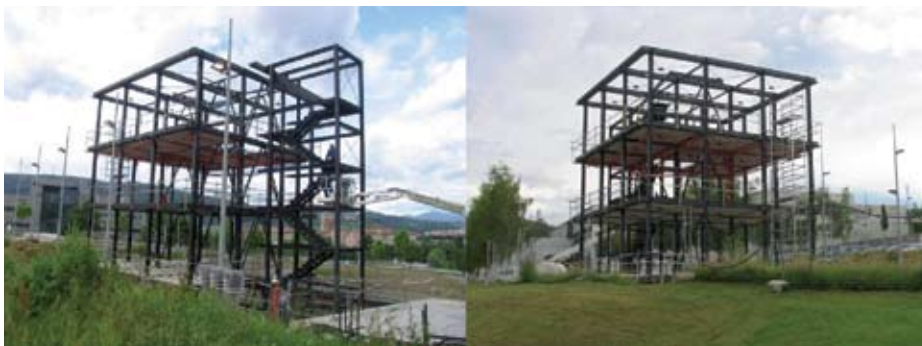
Estructura de acero desmontable ya finalizada.
